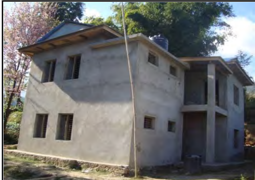
निर्माणाधिन अवस्थामा रहेको गोगने गाउँ विकास समितिको कार्यालय भवन ।
