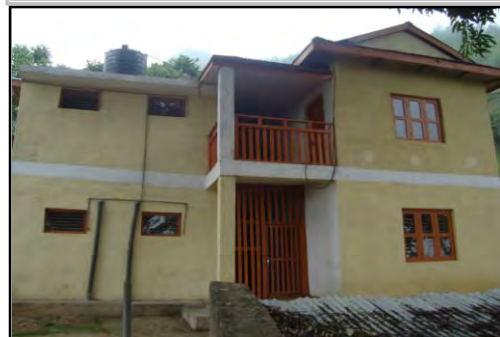
निर्माण पूरा भएको ठूलोदुम्मा गाविसस्थित गाविस कार्यालयको भवन सञ्चालनमा आइसकेको छ ।
