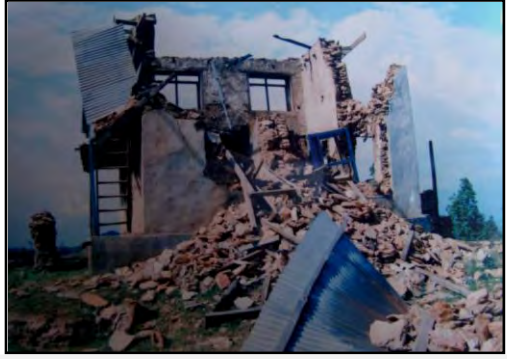
सशस्त्र संघर्षका क्रममा माओवादीले आक्रमण गरेर ध्वस्त बनाएको प्रहरी चौकी प्याउलीको भवन । सो भवन शान्ति प्रक्रिया पछि अहिलेसम्म पनि पुनःनिर्माण हुन सकेको छैन ।
