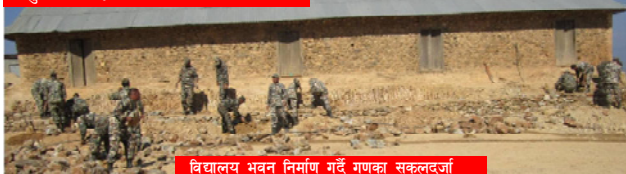
विद्यालय भवन निर्माण गर्दै गणका सकलदर्जा
